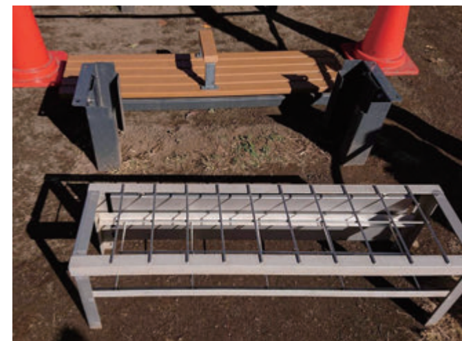
高井戸公園のベンチの座面を外すと、災害時に使える「かまど」が現れます
